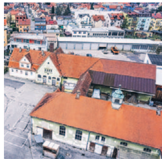
Der Alte Schlachthof soll saniert werden.
